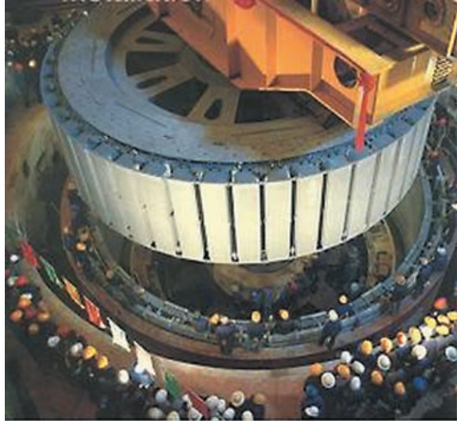
图 2-2 正在吊装的大型发电机的转子和定子
