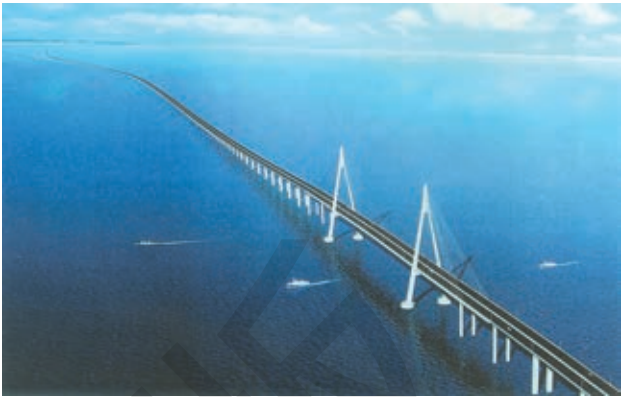
图 1-32 建造中的宁波跨海大桥
