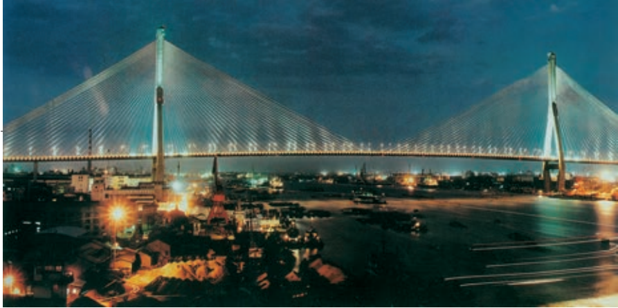
图 1-30 上海杨浦大桥
