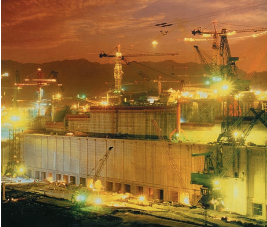
图 2-1 繁忙的建筑工地
