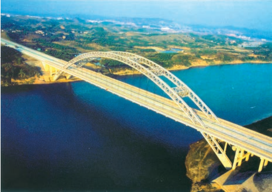
图 1-12 广西邕江大桥
